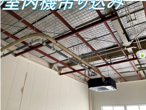
③ 天井用の軽天下地を支える為、既存梁間に鉄骨を設置。新規に空調機 室内機を吊り込みます。
