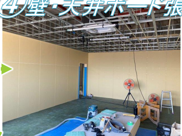
④ 壁、天井へボード張りを行っていきます。だんだんと完成が見えてきました！
