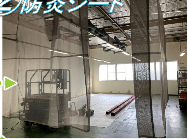
② 備品を移動し既存の床材を撤去。安全の為に工事区画を防災シートにて囲い込みを行います。
