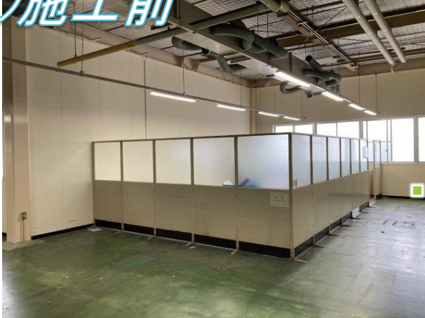
① 施工前の全体写真です。今回はパーティションで仕切られていた会議室をしっかりと壁で区切ります。
