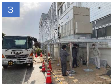
3、4 架台の上に非常用発電機を設置！
