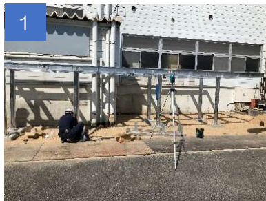
1、2 前号で完成した架台にフェンスを取り付けます。
