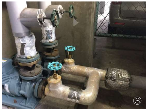
①吸水バルブ交換後 ②揚水ポンプ交換後 ③吸水配管保温材施行後 ④吸水配管ラッキング施行後
